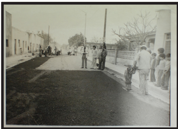
Proceso de pavimentación de la calle Morelos y Colón. 1977.
