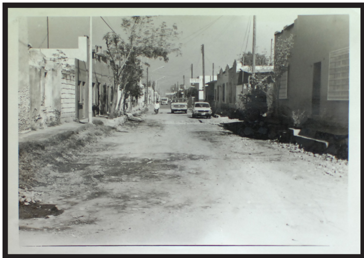
En calle Zona Oriente hoy Av. Arturo B. de la Garza cruz con Bernardo Reyes. las calles estaba sin pavimentar, 1977
