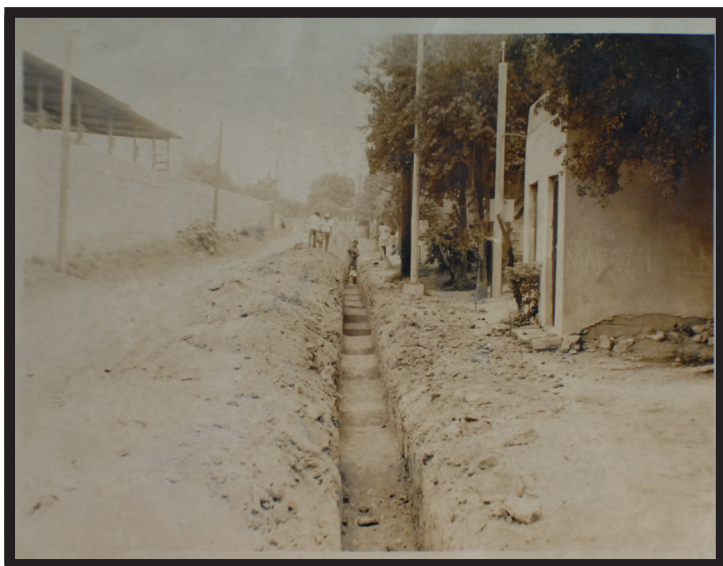
En la pavimentación de las calles Allende, Madero y Zaragoza, mayo 1977.
