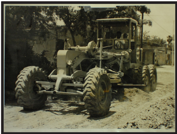
Trabajando en la pavimentación de calles, en ese momento eran de tierra, calle Zaragoza e Hidalgo, 1977.
